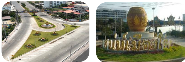
รูปที่ 31 งานก่อสร้างงานภูมิสถาปัตยกรรม การปรับปรุงภูมิทัศน์บริเวณทางแยกถนนเทศบาล
