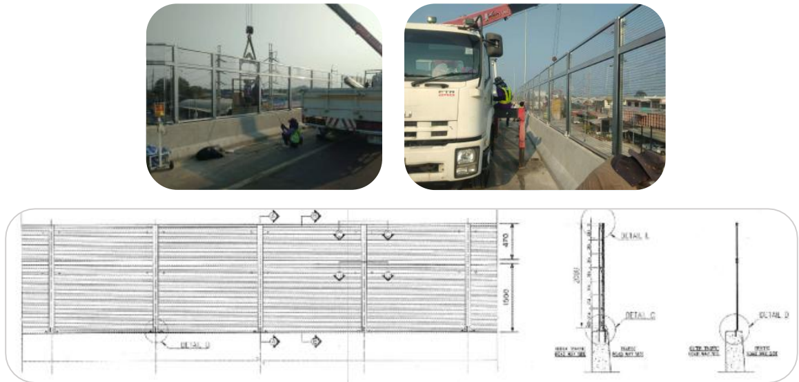
รูปที่ 30 การติดตั้งกำแพงกันเสียง ชนิดอะคริลิกใส (Transparent Acrylic Noise Barrier) และแบบการก่อสร้าง
