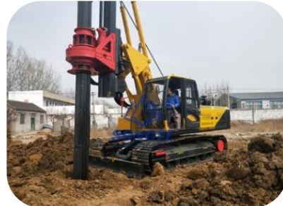
รูปที่ 19 กิจกรรมการการสัด การเจาะเข็มในระยะก่อสร้างโครงการ
