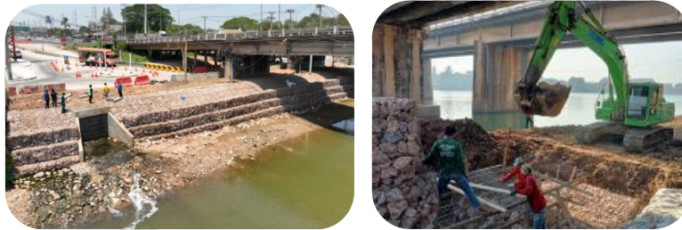
รูปที่ 28 บ่อตกตะกอน (Manhole Type J) และเชื่อมป้องกันตลิ่ง
