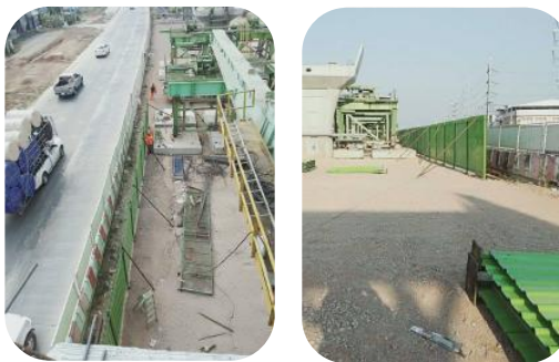
รูปที่ 29 การติดตั้งกำแพงกันเสียงชั่วคราว ชนิดเมทัลชีท (Metal Sheet)
