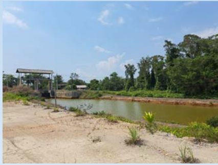
รูปที่ 3 ก่อสร้างสะพานข้ามคลองกระแจะ
