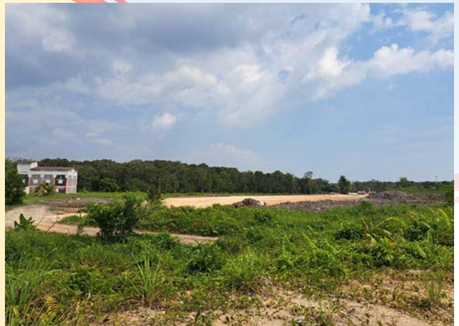
รูปที่ 6 จุดสิ้นสุดโครงการ เชื่อมต่อกับถนนสาย ข ที่กำลังก่อสร้าง
