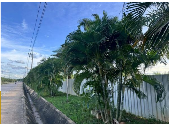
พื้นที่โรงไฟฟ้า
