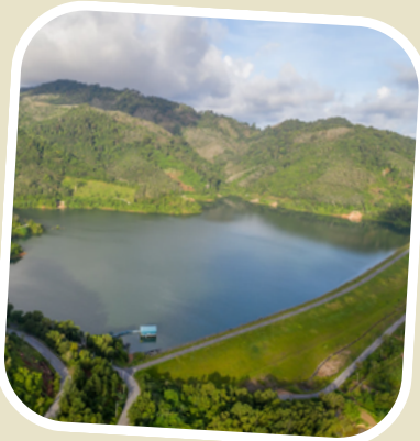
อ่างเก็บน้ำ (RESERVOIR)
