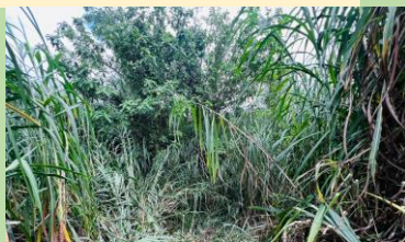
รูปที่ 4 จุดระบายน้ำฝน
