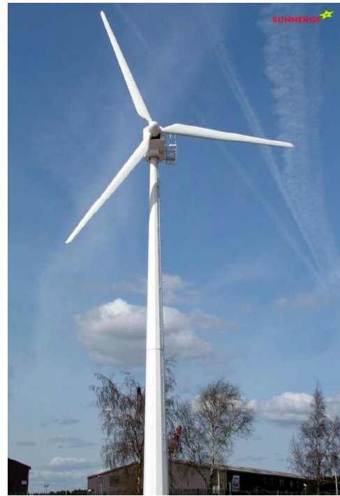
ตัวอย่างรูป กังหันลมแนวแกนนอน (Horizontal Axis Wind Turbine)
