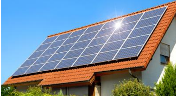
ตัวอย่างรูป การติดตั้งแผงโซลาร์เซลล์บนหลังคาบ้าน/ อาคารต่างๆ (Solar Rooftop)
