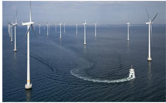
กังหันลมนอกชายฝั่ง Kentish Flats Offshore Wind Farm นอกชายฝั่งเค้น ประเทศอังกฤษ
