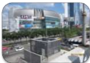
บริเวณพื้นที่โครงการ รถไฟฟ้าสายสีส้ม
